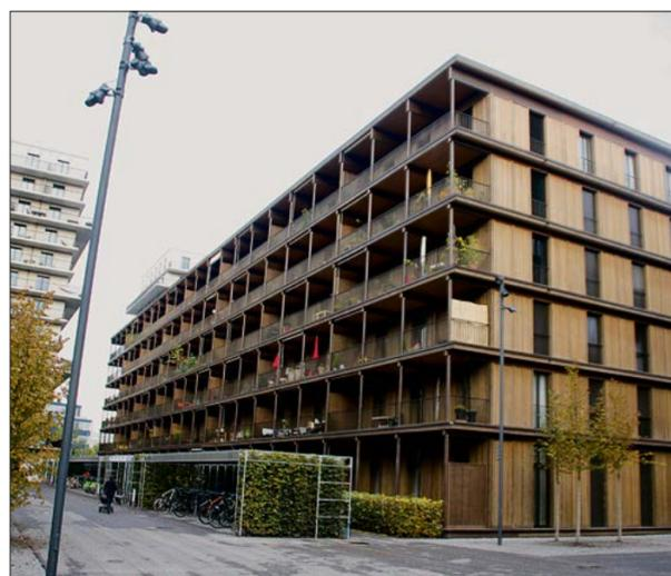
Die mehrgeschossigen Holzbauten sind mit einer Aussenver-schalung mit Holz aus dem Emmental versehen.
